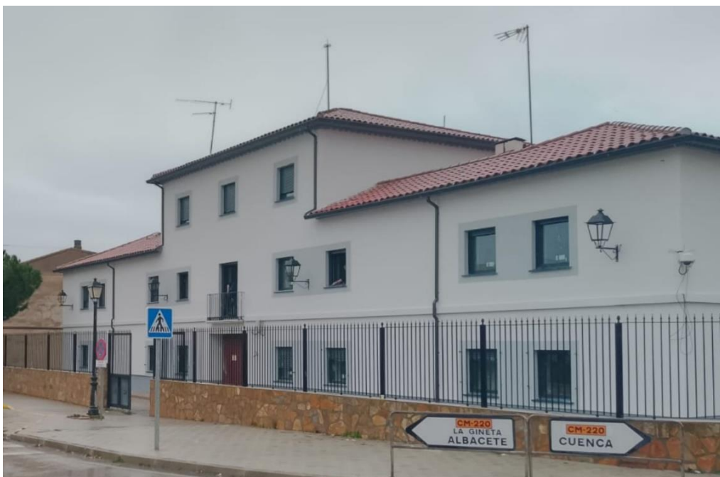
Fachada del Cuartel de la Guardia Civil de Tarazona de la Mancha
