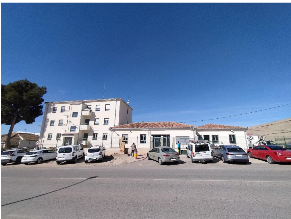
Fachada del Cuartel de la Guardia Civil de Montealegre del Castillo
