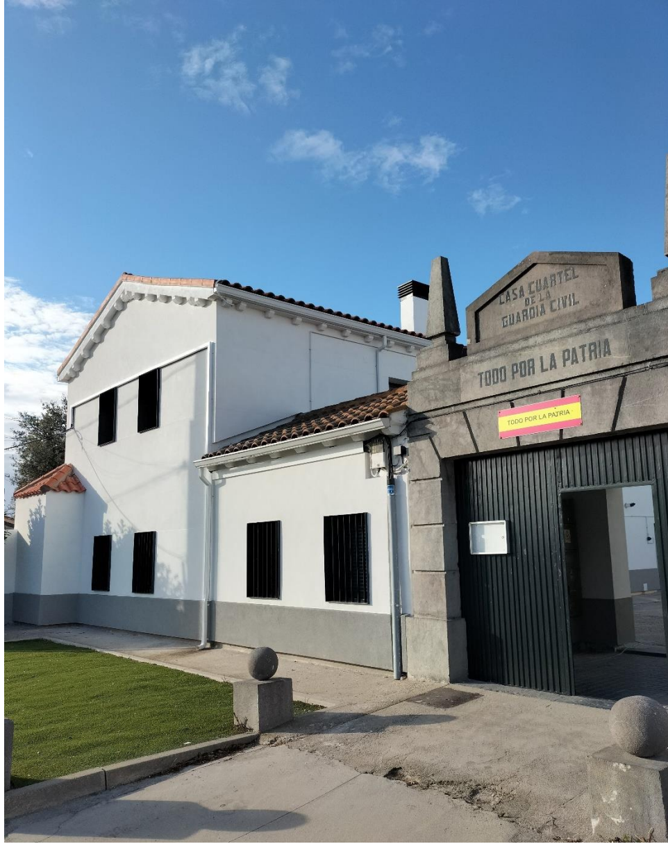
Fachada del acuartelamiento de Fontiveros
