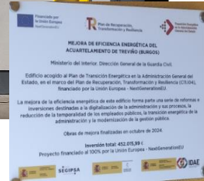
Fachada principal del acuartelamiento de Condado de Treviño y detalle de la publicidad de la financiación de la obra.
