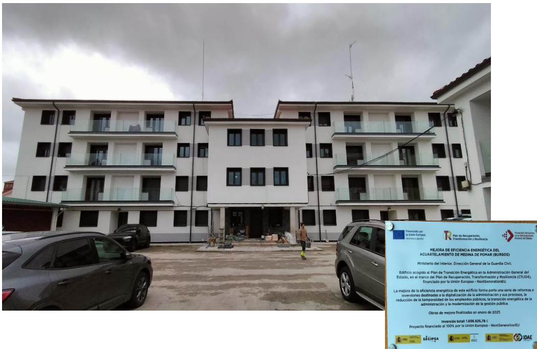
Fachada rehabilitada de la Casa Cuartel de Medina de Pomar y detalle de la publicidad de financiación de la obra
