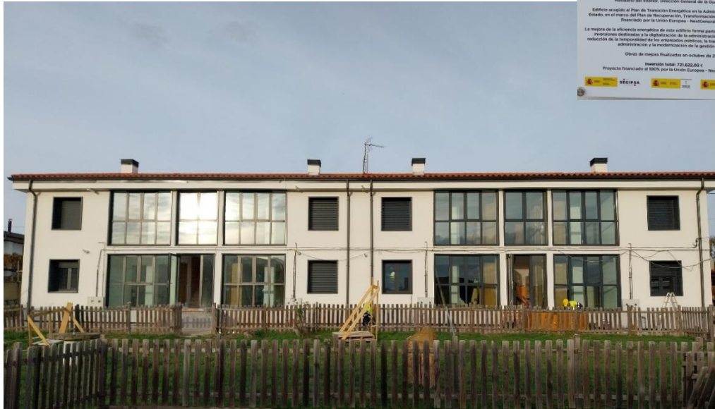
Fachada exterior del acuartelamiento de Quincoces de Yuso y detalle de la publicidad de la financiación de la obra.
