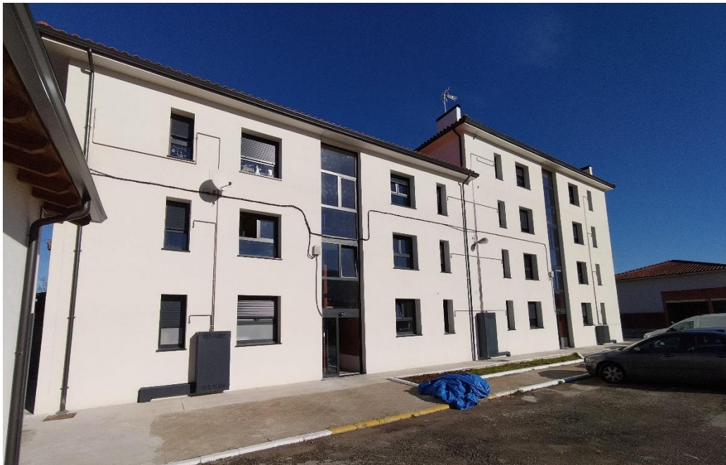
Fachada lateral rehabilitada del acuartelamiento de Cabezón de la Sal
