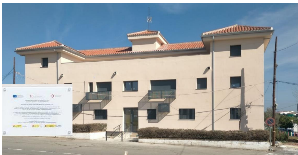
Fachada de la Casa Cuartel de la Guardia Civil de Beas y detalle de la publicidad de la financiación de la obra
