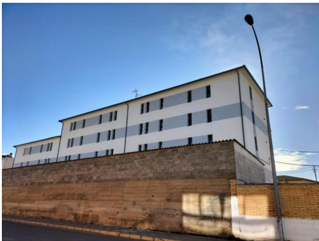
Fachada lateral del acuartelamiento de Binéfar
