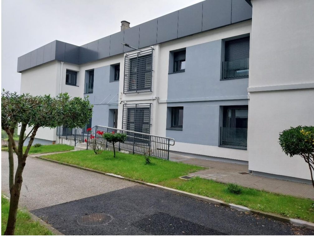
Patio interior del Cuartel de la Guardia Civil de Xove
