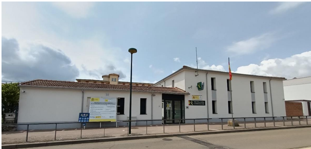
Fachada principal del acuartelamiento de Aguilar de Campo
