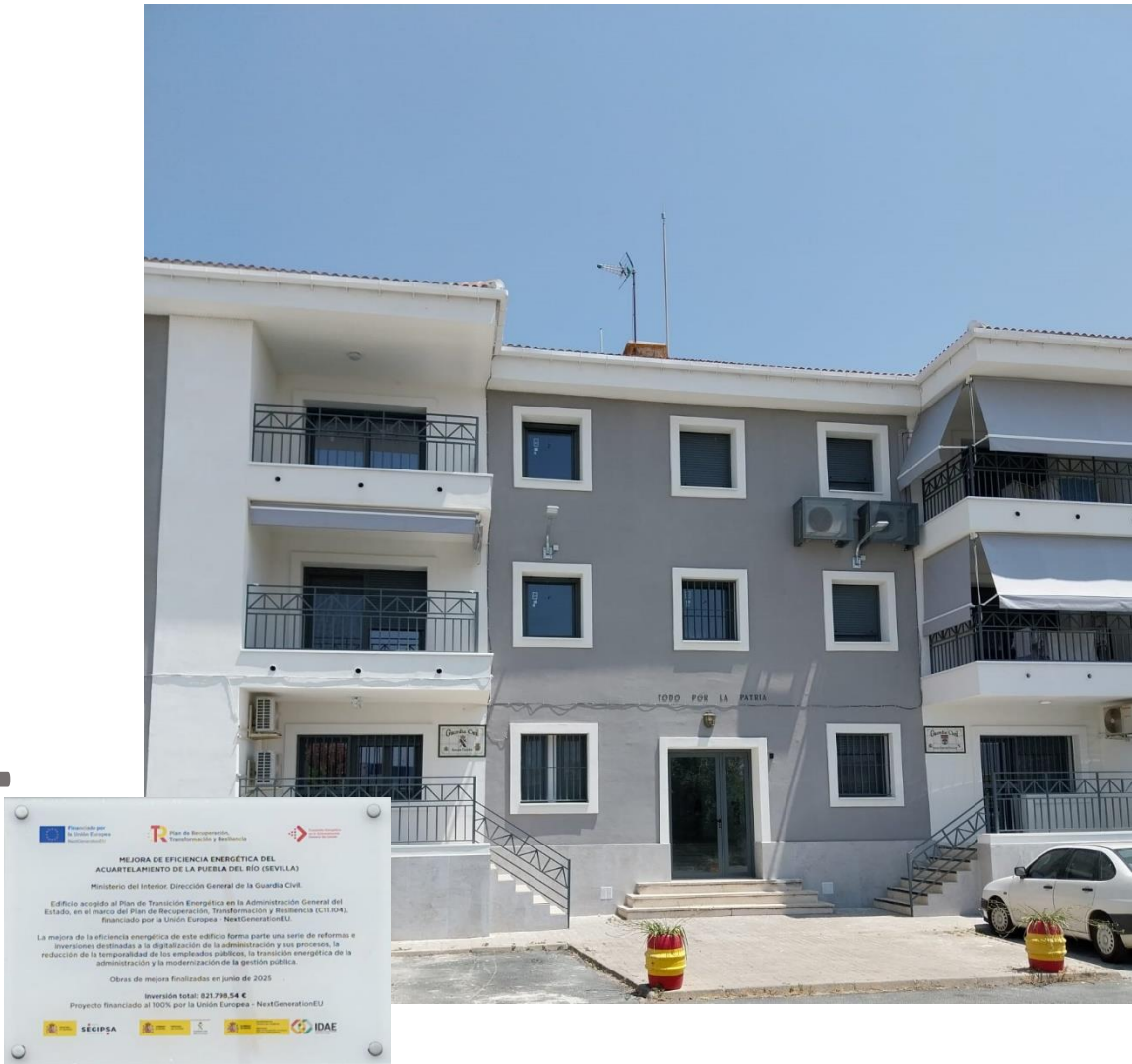
Fachada rehabilitada de la Casa cuartel de la Guardia Civil de La Puebla del Río y detalle de la publicidad de la financiación de la obra
