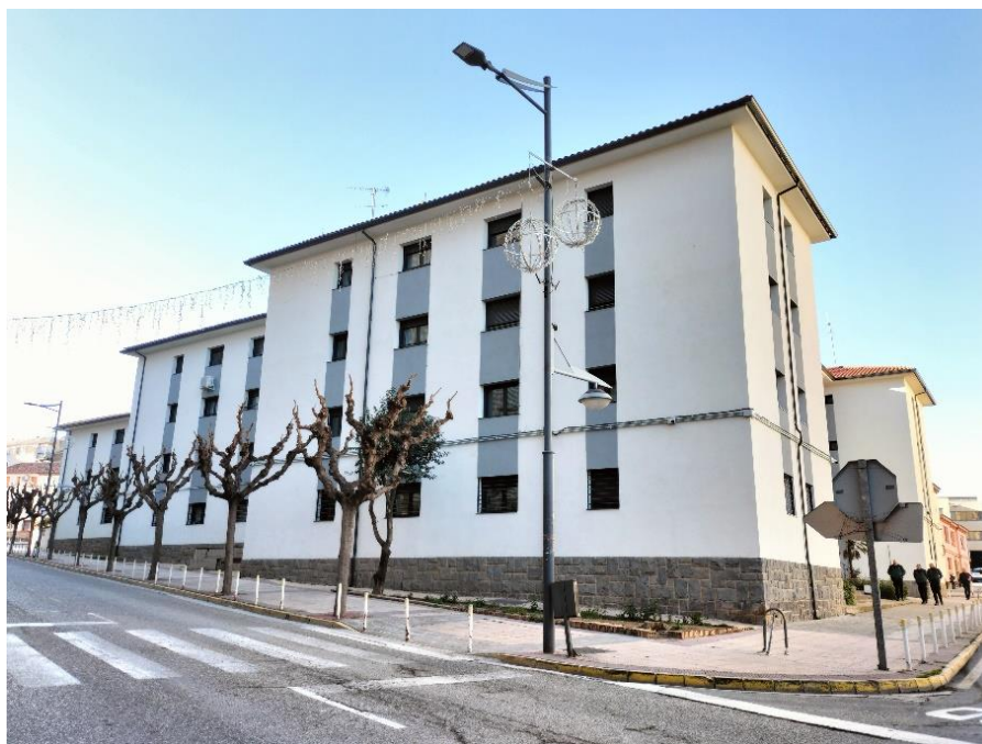
Vista del lateral del Cuartel de la Guardia Civil de Alcañiz
