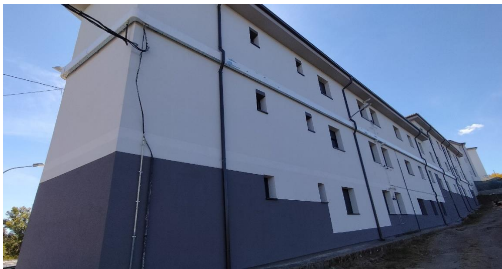
Exterior del Cuartel de la Guardia Civil de Puebla de Sanabria
