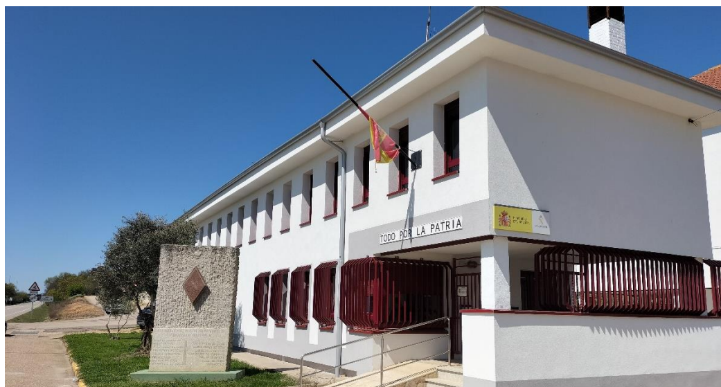
Frontal del Cuartel de la Guardia Civil de Camarzana de Tera
