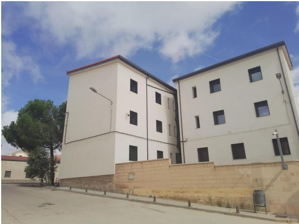
Vista lateral del Acuartelamiento de la Guardia Civil de Gómara (Soria)
