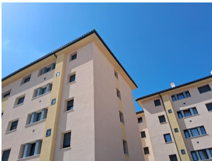
Acuartelamiento de Tarifa, Cádiz
